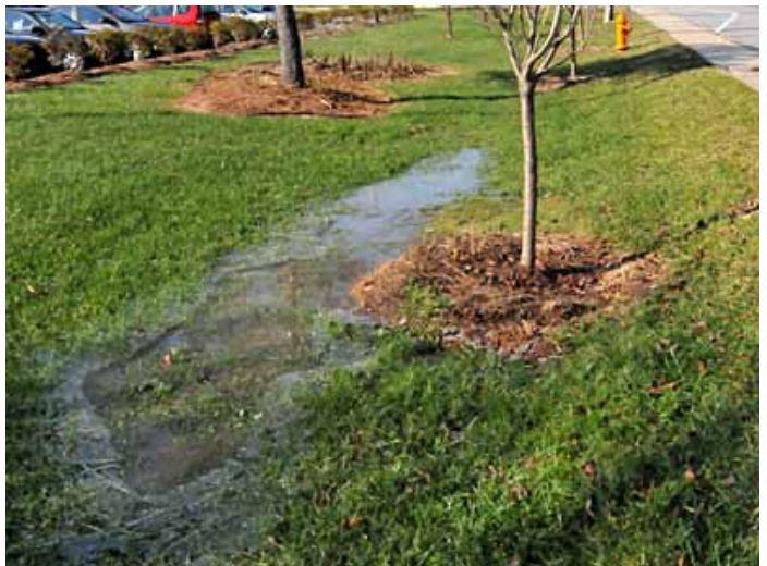
Check site drainage.
