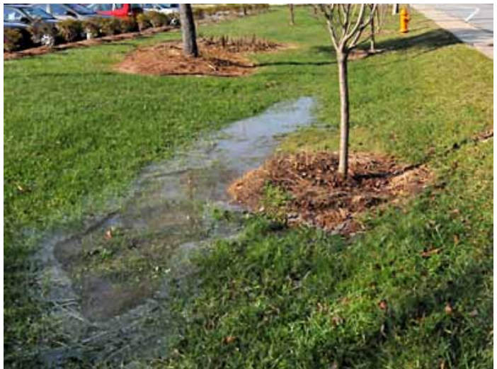
Check site drainage.
